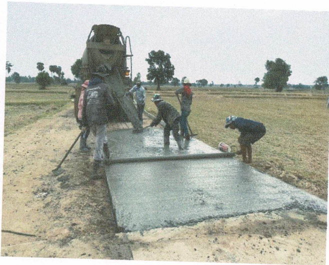
โครงการก่อสร้างถนนคอนกรีตเสริมเหล็กสามแยกหนองข้างต่ายบ้านโคกสูงหมู่ที่ ๓ ไปโรงเรียนบ้านโคกสูง
