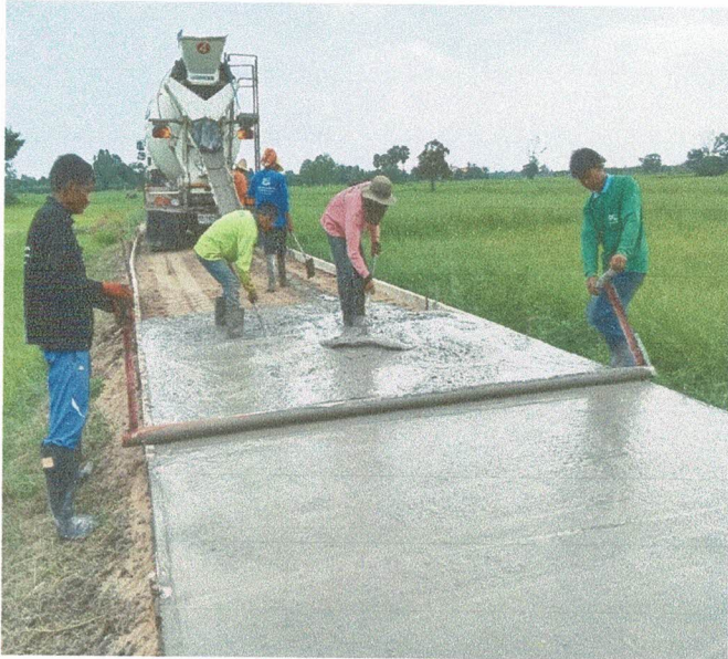
โครงการก่อสร้างถนนคอนกรีตเสริมเหล็ก บ้านตะแบก หมู่ที่ ๔ ไปทางโรงเรียนบ้านห้วยสำราญ ตำบลห้วยสำราญ
