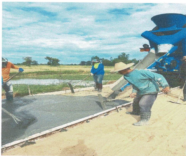
โครงการก่อสร้างถนนคอนกรีตเสริมเหล็กต่อจากถนนเดิมบ้านตาฮ้อ หมู่ที่ ๕ ไปทางบ้านตะแบก หมู่ที่ ๔
